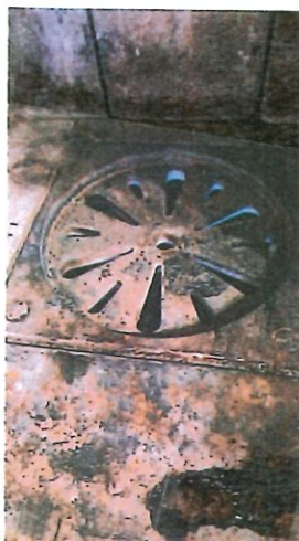
1. Rost entfernen und aufbewahren
