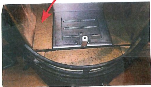
5. Ringsum mit Vermiculiteplatte passend zuschneiden
