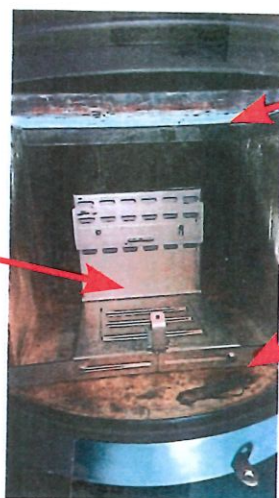
5. Ringsum mit Vermiculiteplatte passend zuschneiden
